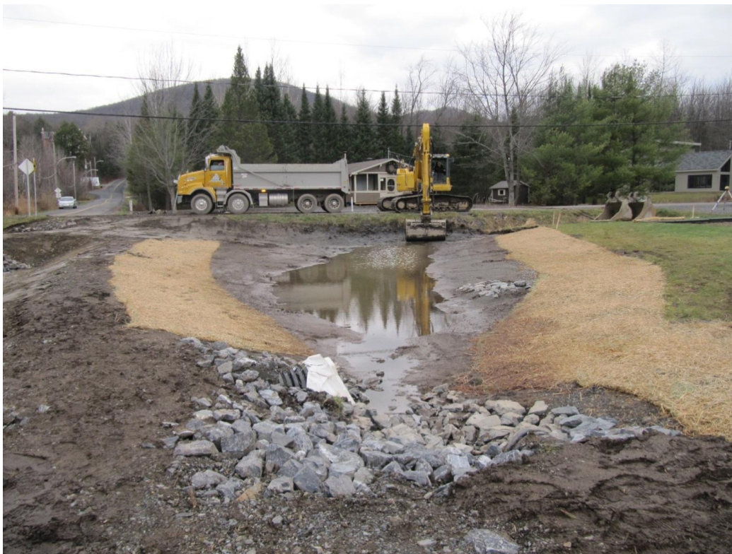
Figure 38 : Aménagement d'un marais filtrant à écoulement de surface en bordure du lac Bromont, au Québec. Source : Présentation donnée dans le cadre du forum de l'eau 2015 de la Yamaska
